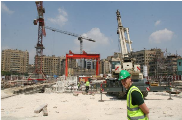
Chantier: métro du CAIRE (EGYPTE)
