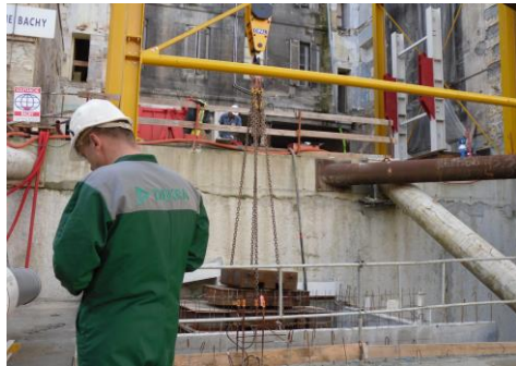
Réception DEKRA Chantier SOLETANCHE BACHY à BORDEAUX
